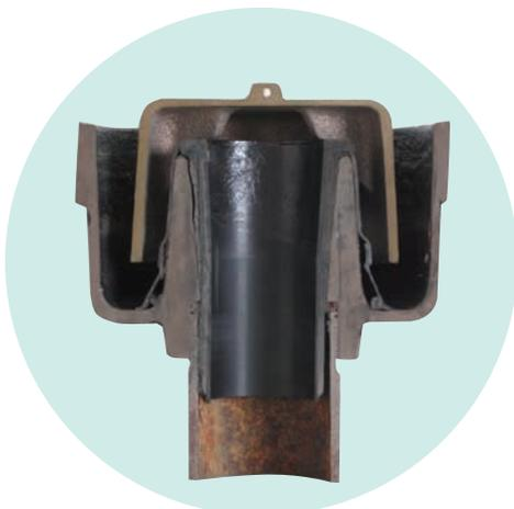
補修後のトラップ断面図
