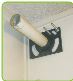
芯合わせ用ガイド アンカー止めプレートを 壁に1点止め
