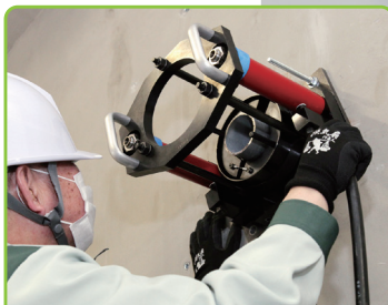
横管引抜作業(大口径)
