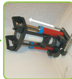
配管引き抜き中
