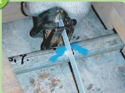
セーバーソーでの切断状況
